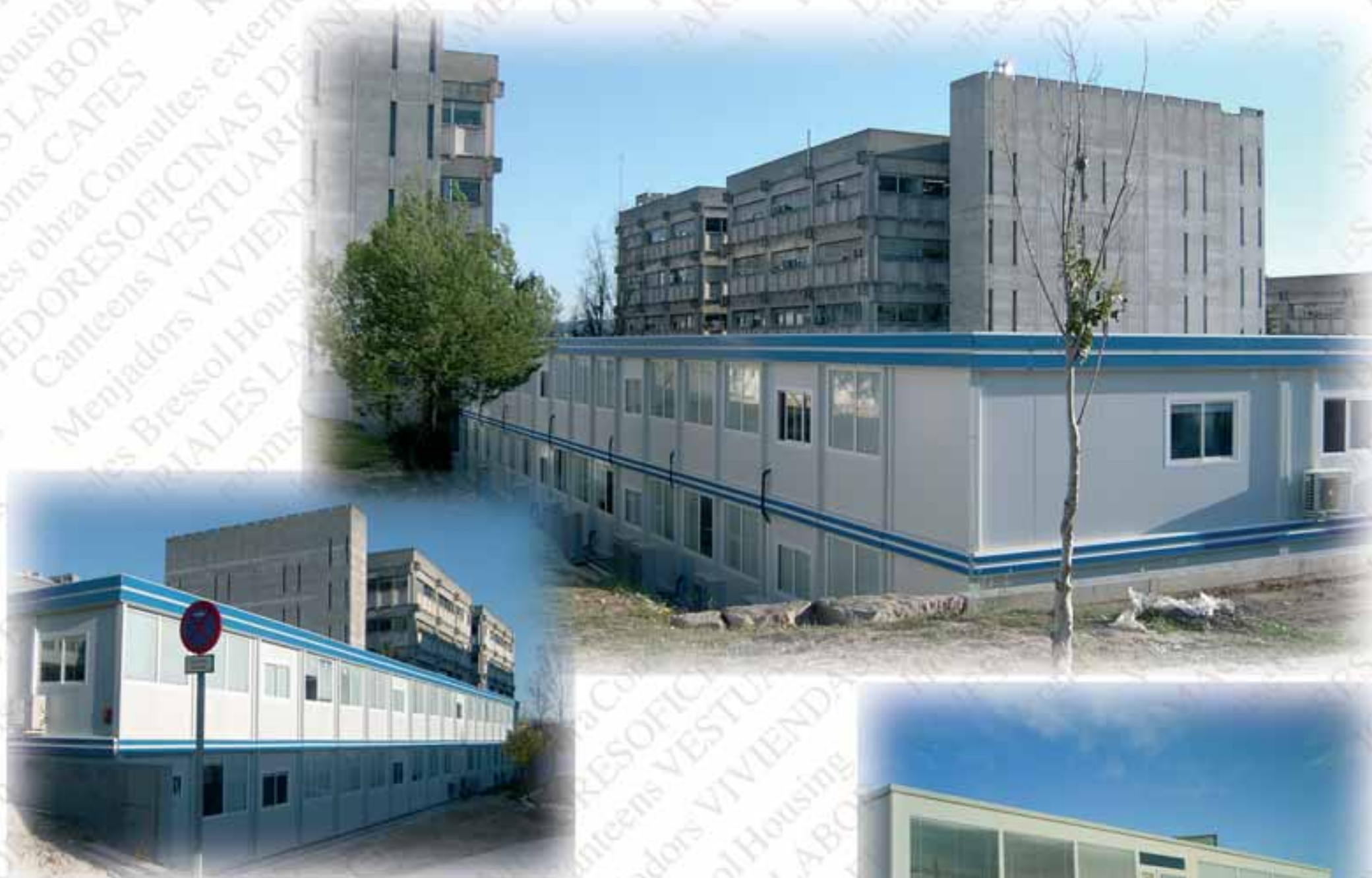
Obra: CELLS de la Universitat Autònoma de Barcelona Superficie: 1036,80 m 2 Delegación de Sant Boi
